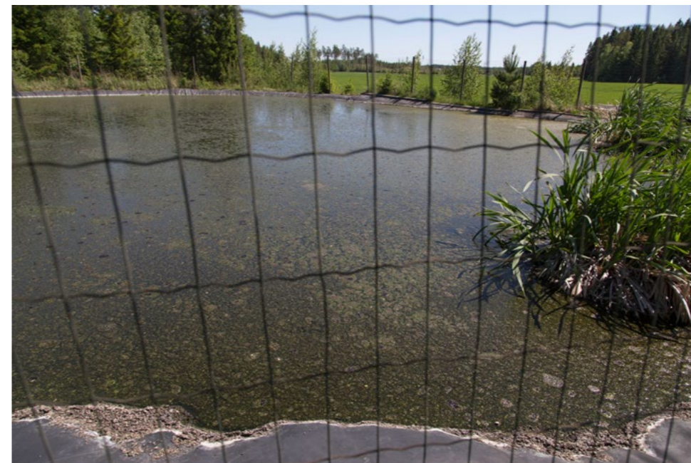
Lietelaguuni on edullinen lietalannan varastoratkaisu. Lietelanta voidaan erillisen kaivon kautta kuormata ilman allaskumin rikkoutumisvaaraa.
