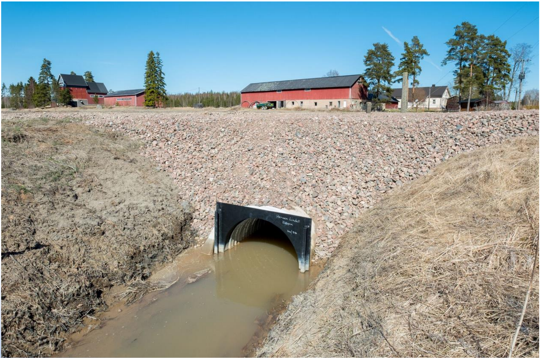
Rummun yhteyteen rakennettu säätöpato uomaeroosion ehkäisemiseksi vesipaineen avulla.
