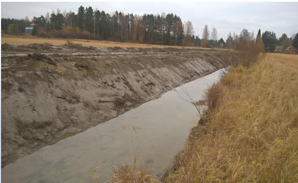
Toispuoleinen varovainen kaivu
