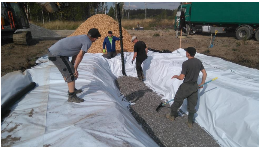
Kalantiin rakennettu salaojavesiä suodattava biohiilisuodattamo rakennusvaiheessa Kuva: Pekka Alho
