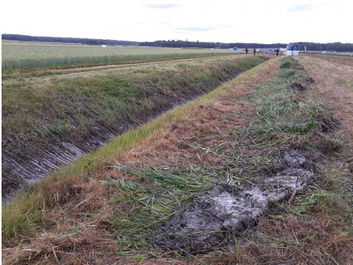
Valtaojien perkaustarvetta voi arvioida puintityön lomassa. Kuvassa niittokauhalla perattu valtaoja. Kuva: Sami Talola
