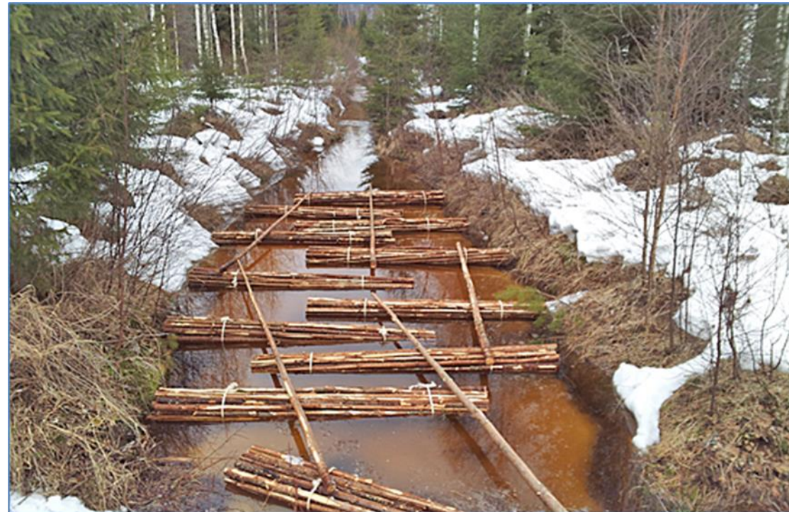
Kuusenrangoista tehtyjä nippuja esiasennettuna laskeutusaltaaseen PuuMaVesi-hankkeen pilottikohteessa. © Kuva: Esko Keskinen
